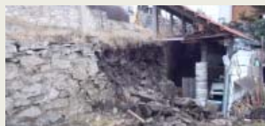
Oprava opěrné zdi se uskuteční v letošním roce.
